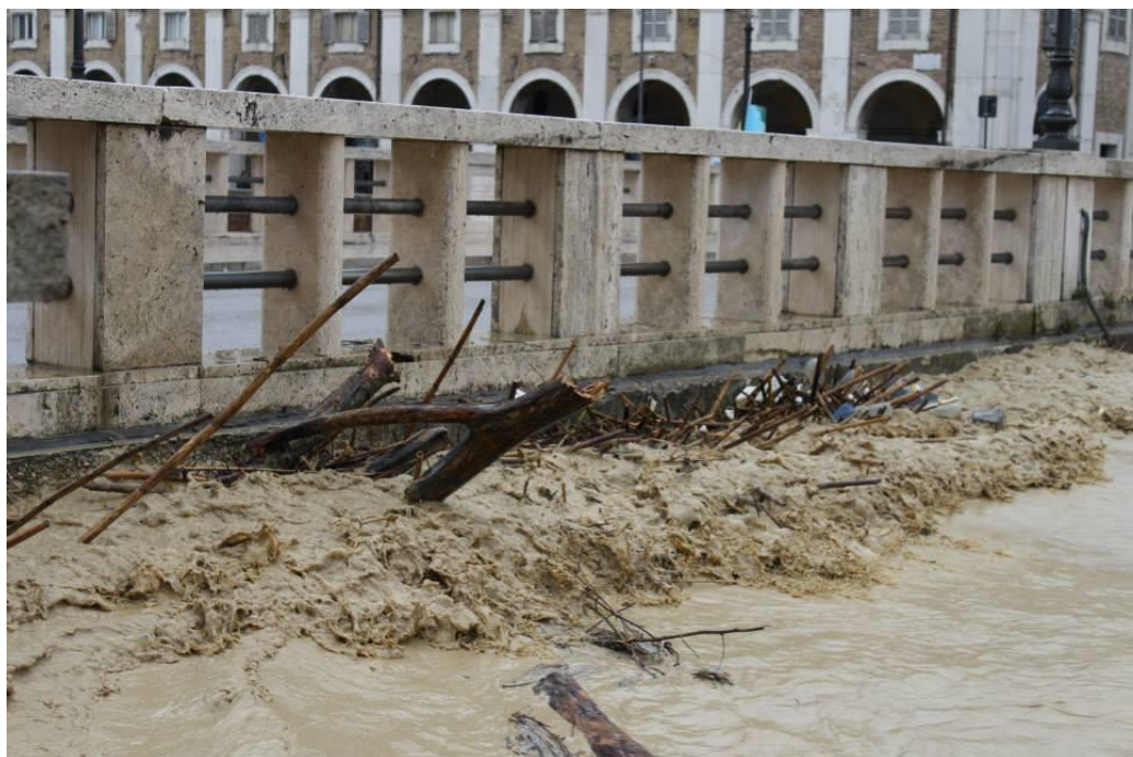
Foto n° 12: sono evidenti i “rigonfiamenti” dell’acqua in corrispondenza delle sottostanti pile e il primo ammassarsi di rami contro la trave del “ponte del Corso”
