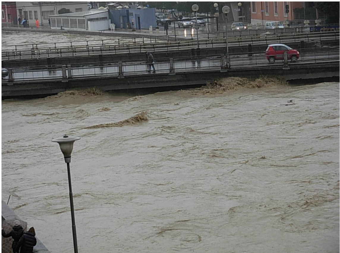
Foto nn° 13 e 14: in queste due foto, il “ponte della Nazionale” durante una piena, con, evidenti, i “rigonfiamenti” dell’acqua in corrispondenza delle sottostanti pile.
