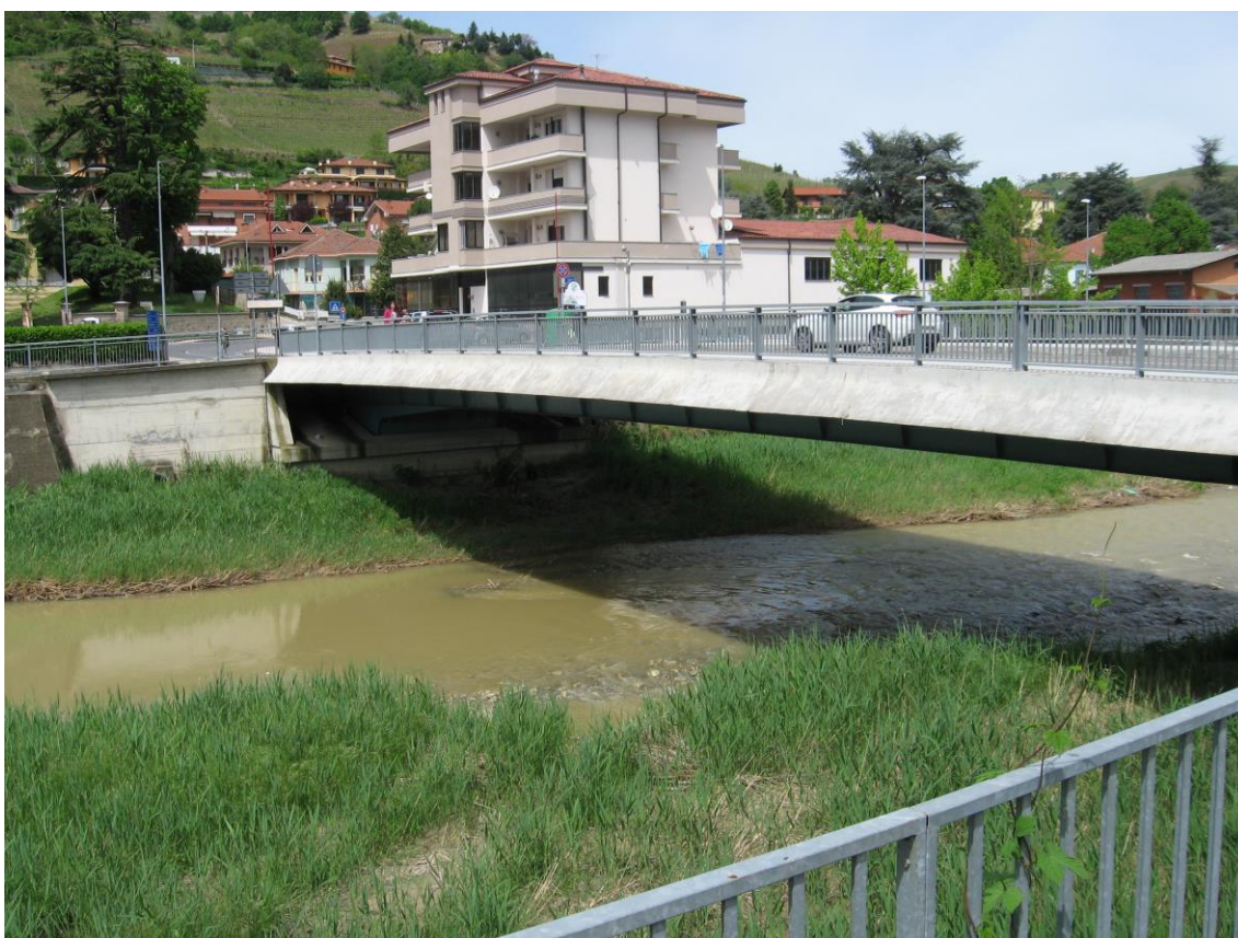
Foto n° 4: il nuovo ponte sul torrente Belbo, a Santo Stefano Belbo (CN), ricostruito finalmente a campata unica dopo la disastrosa alluvione del 1994
