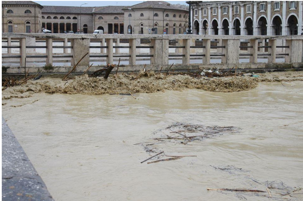
Foto n° 11: i primi “rigurgiti” del fiume Misa contro la trave del “ponte del Corso”, durante una delle piene di fine 2014
