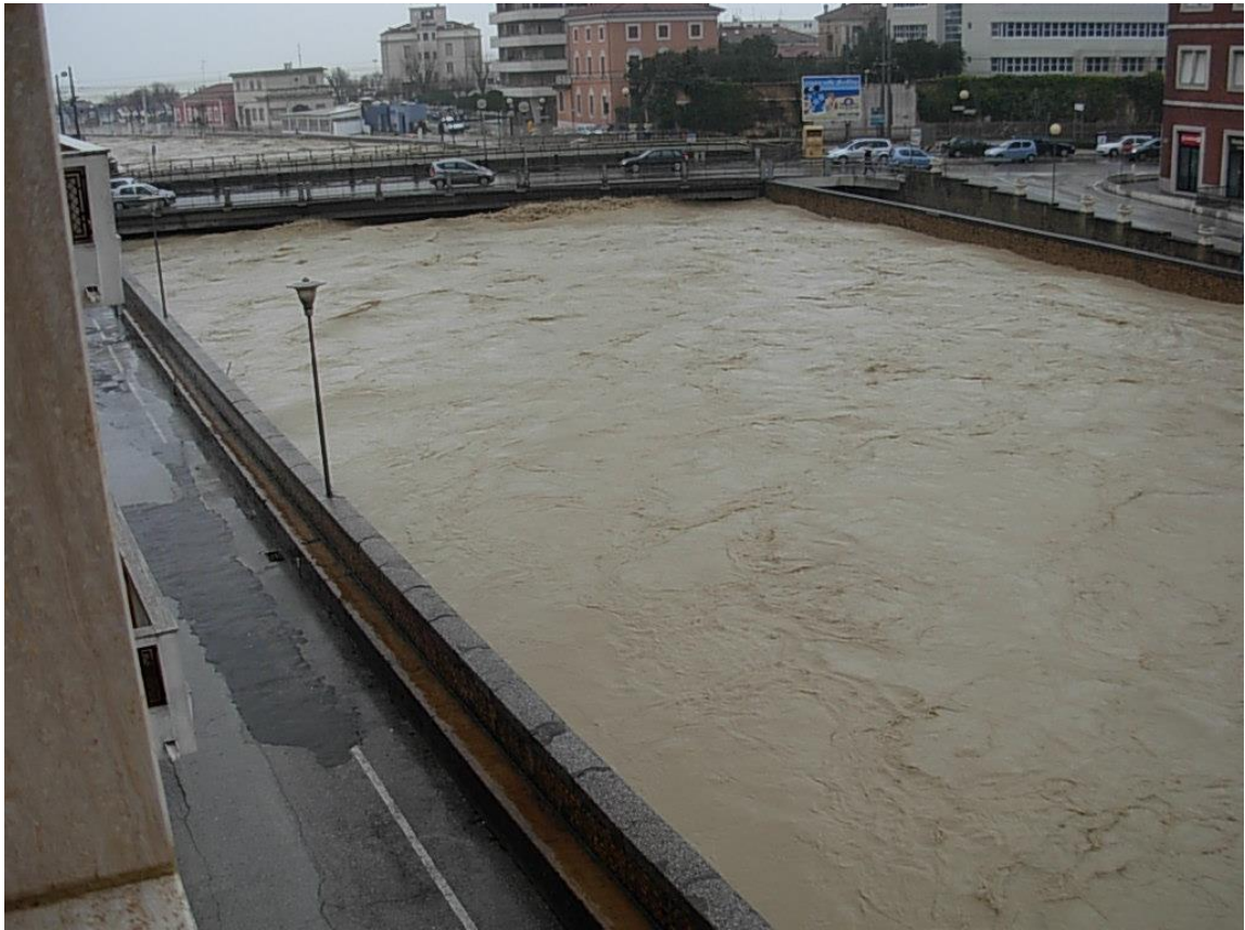
Foto nn° 13 e 14: in queste due foto, il “ponte della Nazionale” durante una piena, con, evidenti, i “rigonfiamenti” dell’acqua in corrispondenza delle sottostanti pile.
