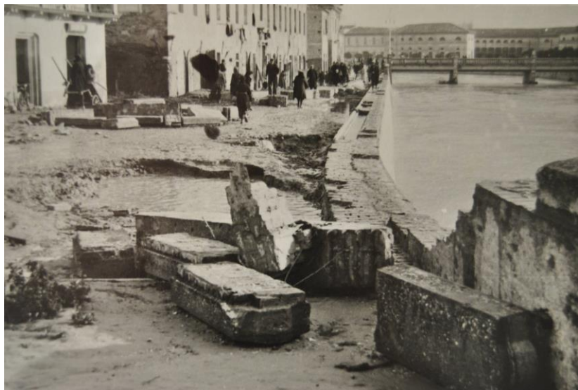
Foto n° 6: 1940, Senigallia, via XX settembre; argine del fiume Misa che ha ceduto in occasione della piena del 1940, con conseguente alluvione
