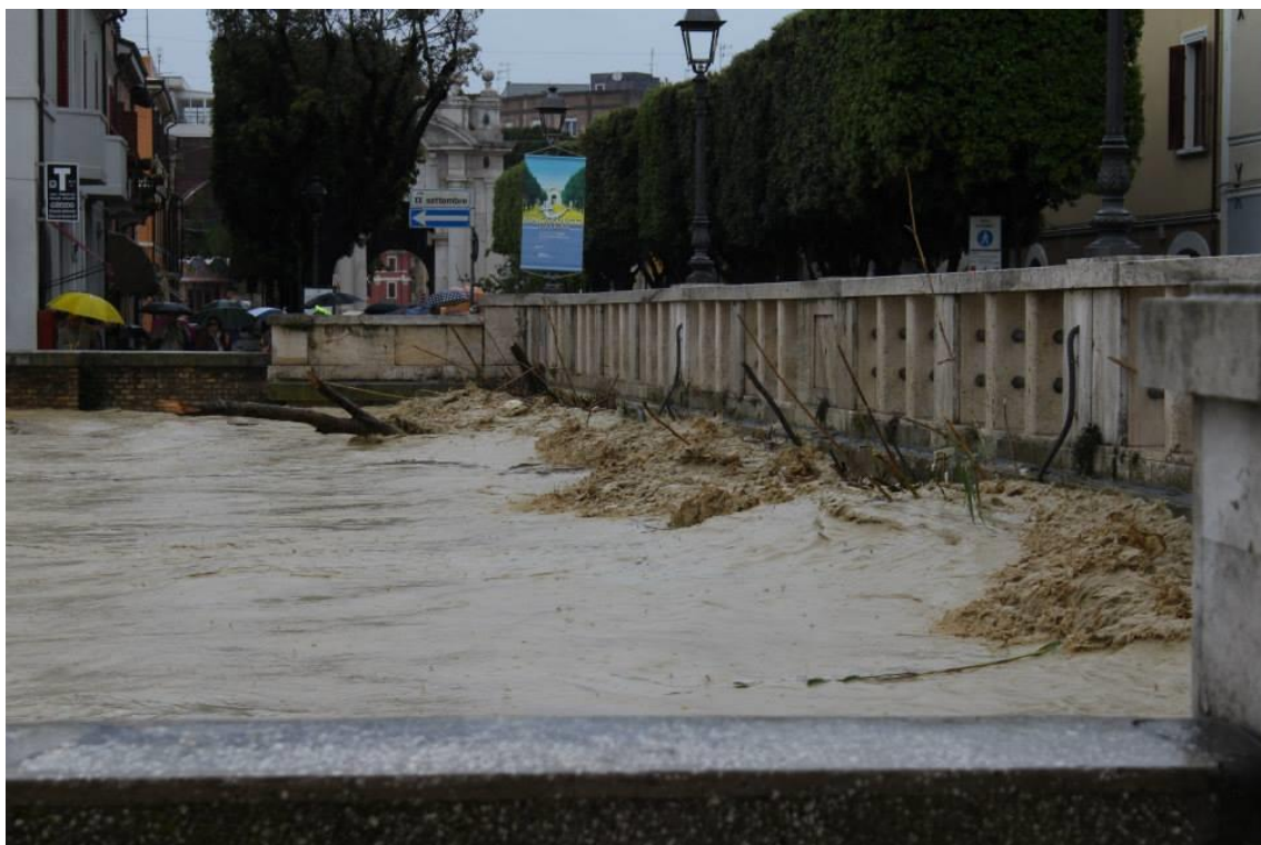
Foto n° 1: il ponte del Corso Il Giugno in occasione di una delle tante piene
