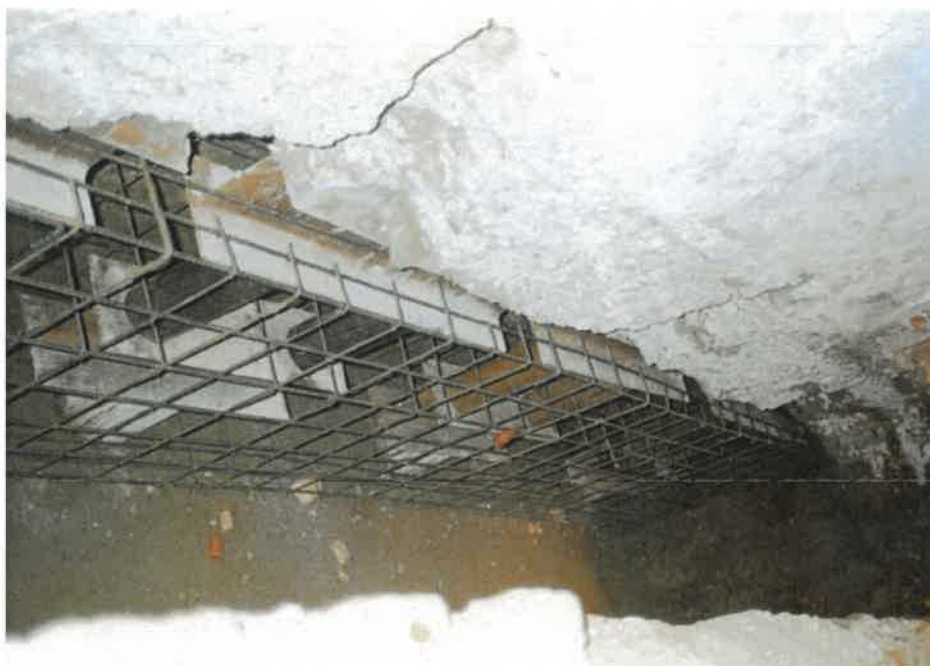
Fig. 8 – realizzazione dell'armatura dei setti in c.a.
