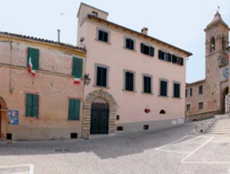
7. Barbara, palazzo Mattei, con ingresso della mostra risorgimentale e porta del ponte levatoio
