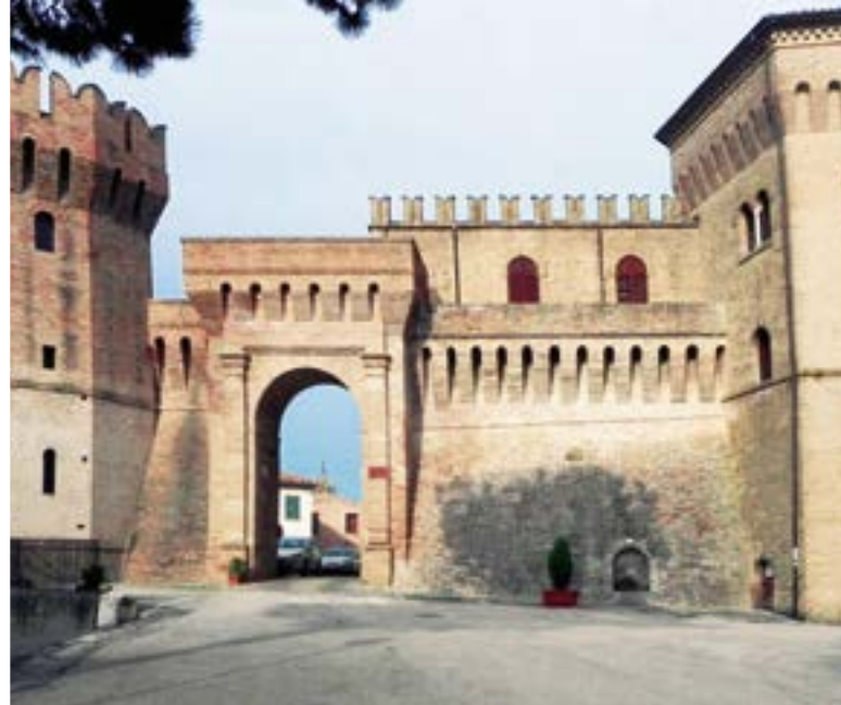
5. Barbara: esterno del palazzo abbaziale, con torre, porta castellana e mastio
