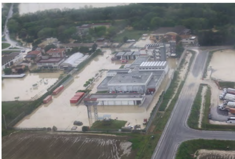
Figura 96: Senigallia - Sede distaccamento Vigili del Fuoco.
