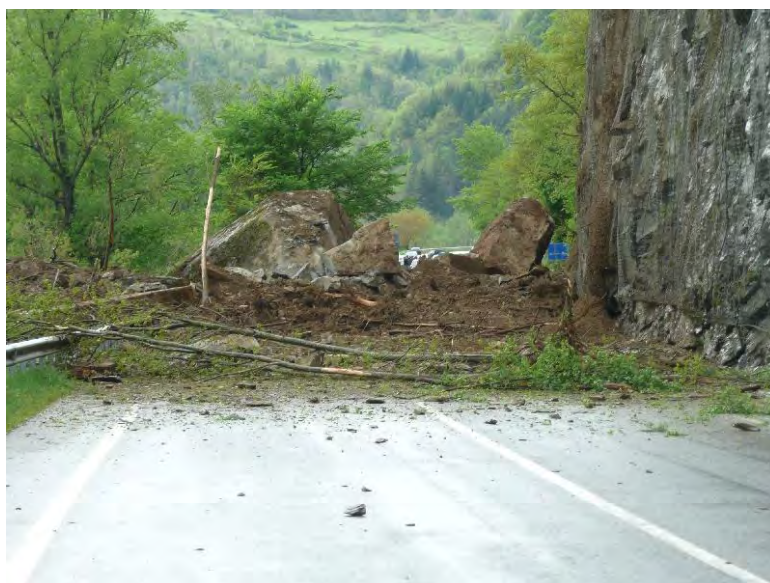
Figura 104: Frana sulla SS Salaria a Trisungo, Arquata del Tronto - Fonte Il Resto del Carlino.
