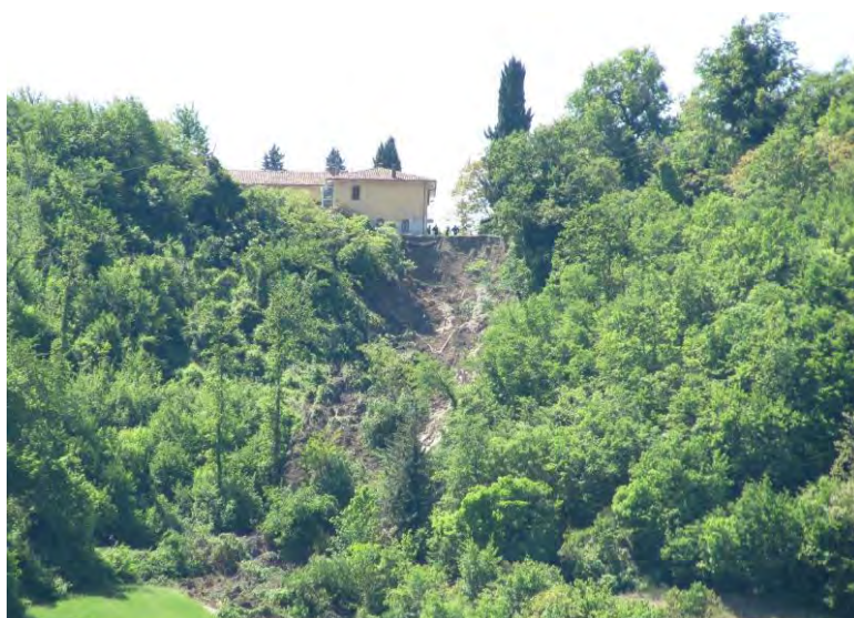
Figura 112: Frana a Pieve di Cagna - Fonte Il Resto del Carlino.
