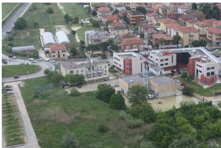
Figura 91: Senigallia - Via G.Bruno - Centrale Telecom.
