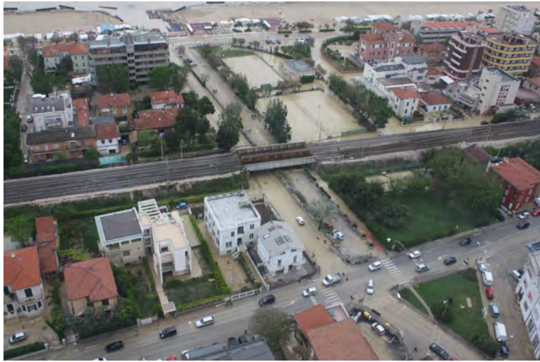
Figura 76: Senigallia - Sottopasso ferroviario di Via Dalmazia e Lungomare Dante Alighieri.
