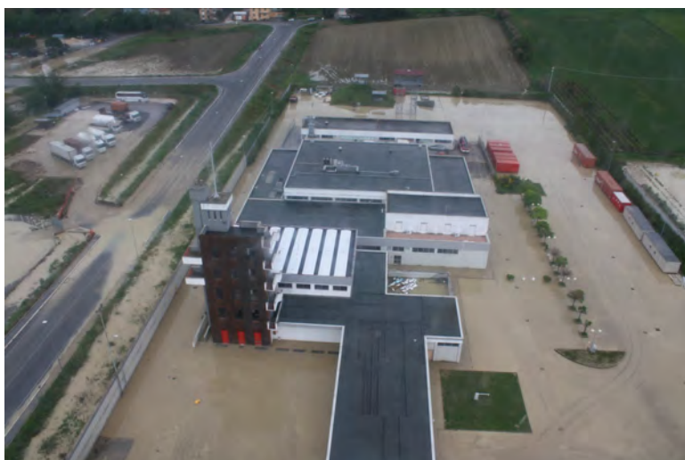
Figura 97: Senigallia - Sede distaccamento Vigili del Fuoco.
