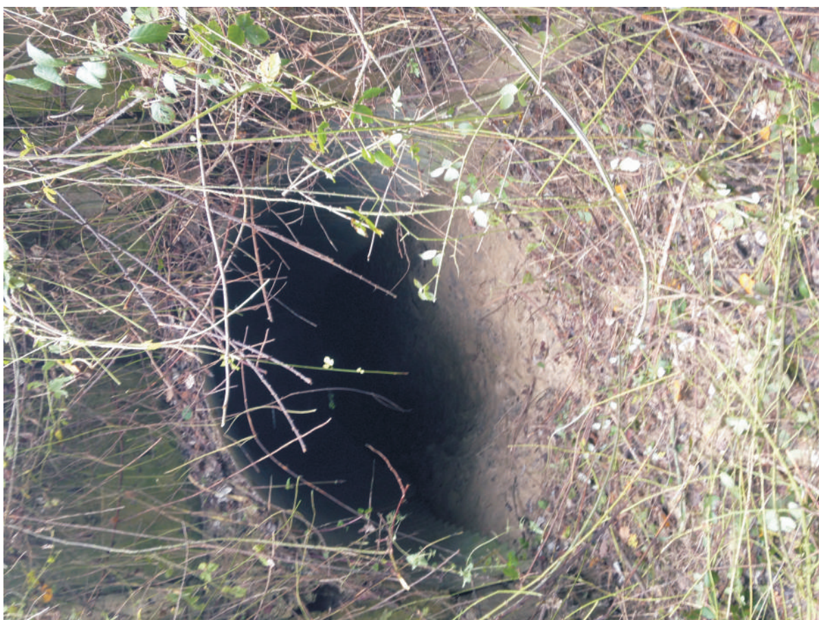
Argine fiume Misa lato Marazzana: Situazione attuale dicembre 2019 dopo l'intervento di pulizia ad opera dei volontari
