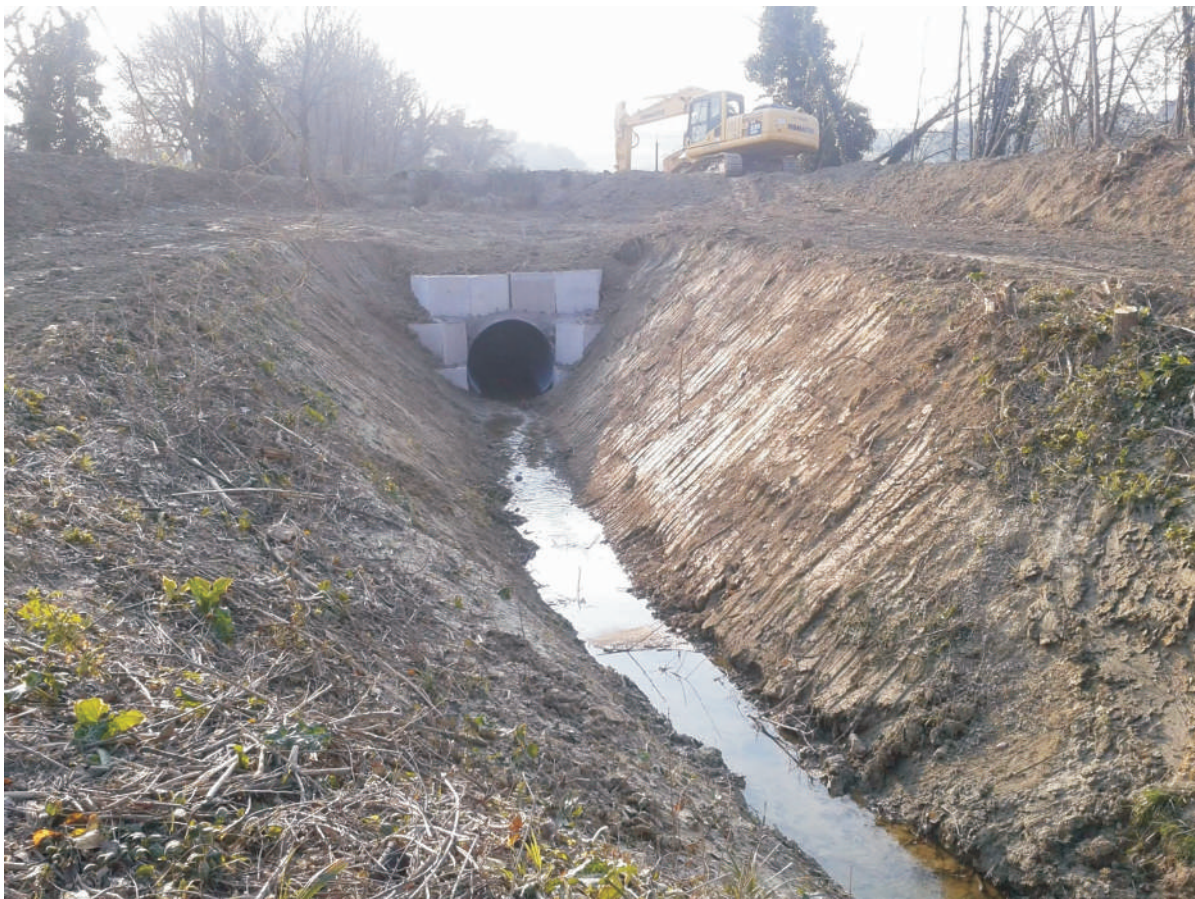
Argine fiume Misa lato Marazzana: Lavori di ripristino dopo alluvione del 2014
